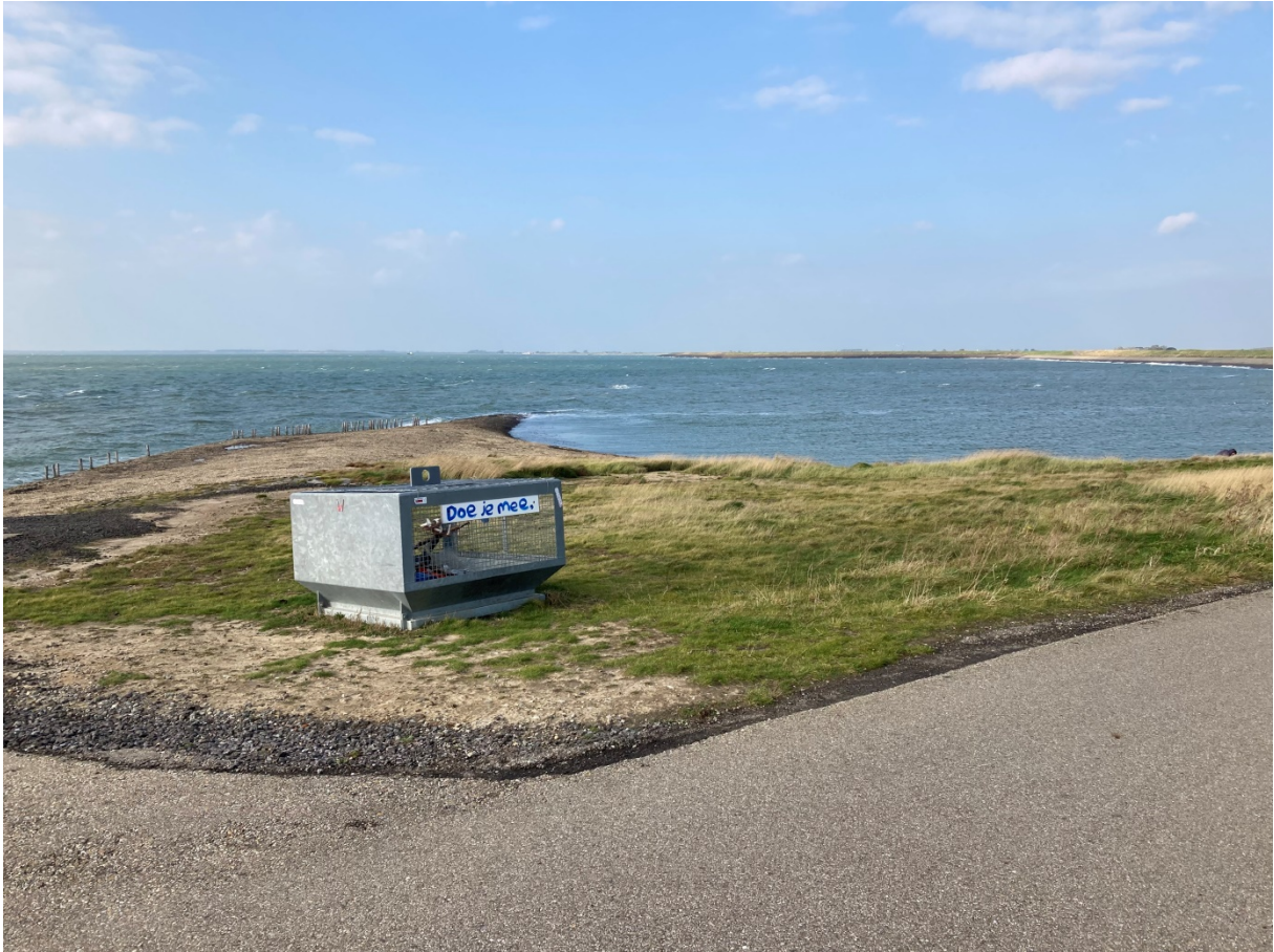
Cauwers Inlaag NW-corner
